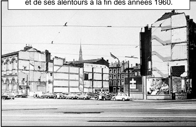
Démolition de l'ancienne bibliothèque des Chiroux et de ses alentours à la fin des années 1960.
