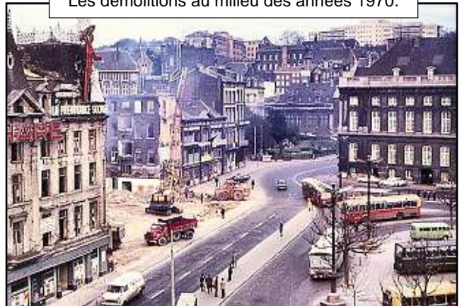
Les démolitions au milieu des années 1970.
