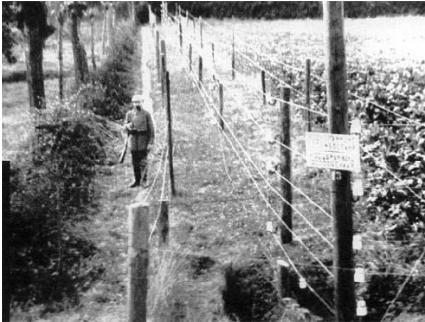
Barrière électrique construite sur la frontière entre la Belgique et les Pays-Bas.
