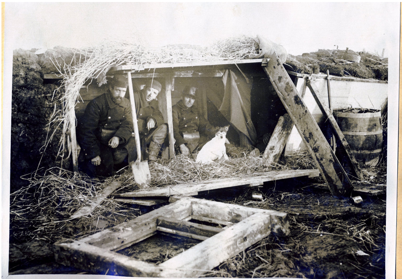
Les tranchées : premières tranchées sommaires; abri en bois et en paille (coll.WHI/MRA)
