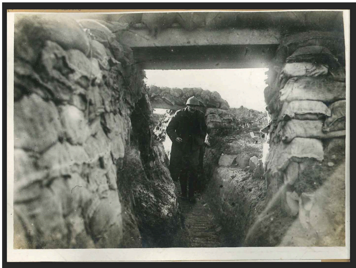
Les tranchées : premières tranchées sommaires; tranchées consolidées par des sacs de sable (Coll. WHI-MRA)
