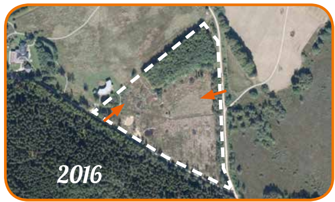
→ Accès à la parcelle
